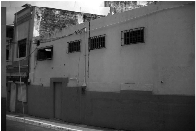
FACHADA OESTE Calle Miguel hidalgo
