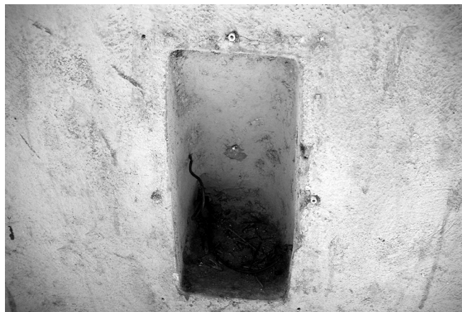
Nichos de iluminación en pilas- tras de pórtico (interior)
