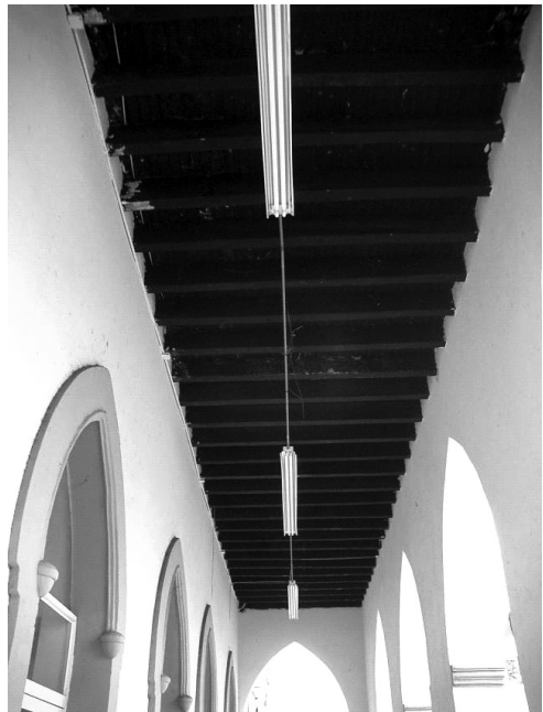
Vista del envigado del pórtico de acceso
