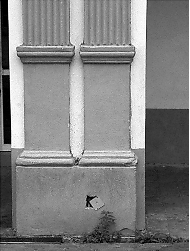
Detalle de los pilares y sus pilastras dobles adosadas (estípites)
