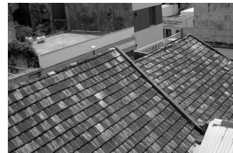
Cubierta a dos aguas de teja.
