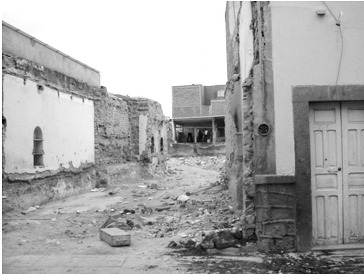
Vecindad demolida en la calle de Pascual M. Hernández, octubre de 2004, San Luis Potosí. (Foto DMG.)
