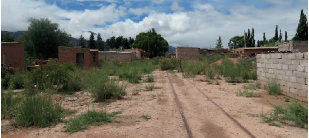
Figura 6: Asentamientos sobre las vías del ferrocarril. Estación Uquía. 2018.
