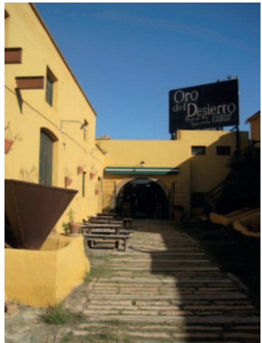
Figura 8 (der.): Patio interior, trojes para el almacenamiento y tolva de recepción.
