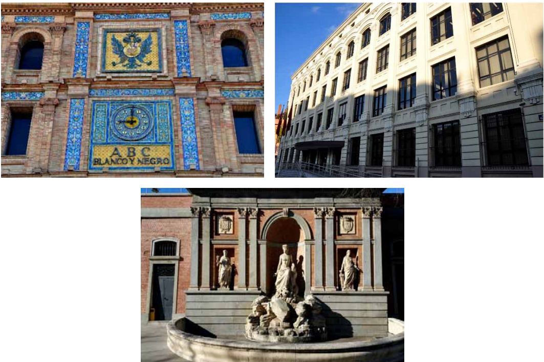
Figura 13: Centro Comercial ABC Serrano (izda.), Empresa Municipal de la Vivienda (dcha.) y Primer Depósito del Canal de Isabel II (abajo)
