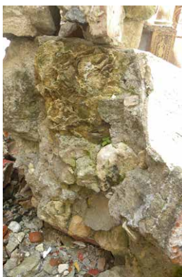
Fotografía 3. Heterogeneidad material en la fábrica de los conjuntos religiosos.
